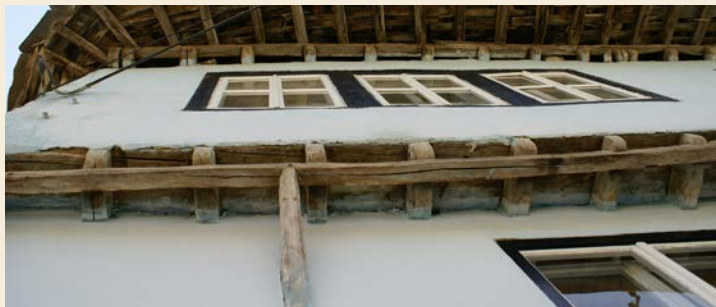
DETAJ I KONZOLLËS CANTILEVER DETAIL
